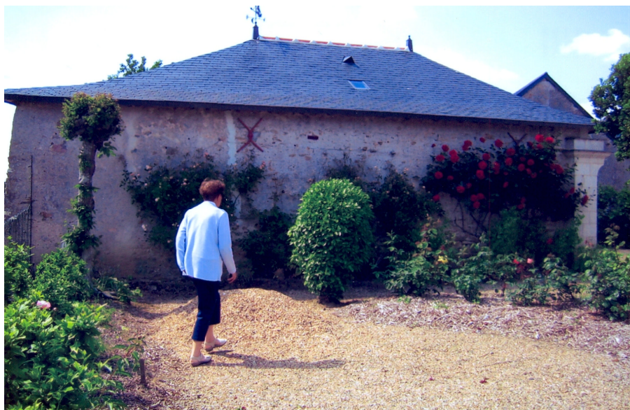
Fig 2. – Le Temple. – Bâtiment sur lequel sont implantés les os
