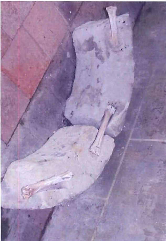
Fig 10, 11, 12, 13. – Chapelle Saint-Roch – Base du clocheton, Goujons reliant des pierres faits en os canons de bovins (document Château-Musée de Saumur).
